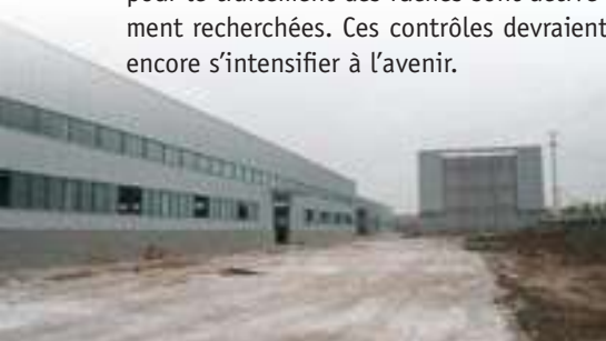
Nouvelle unité de conditionnement pour 10 000 tonnes de miel
